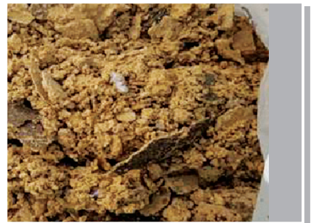
After Cleaning 스케일 청소 후
